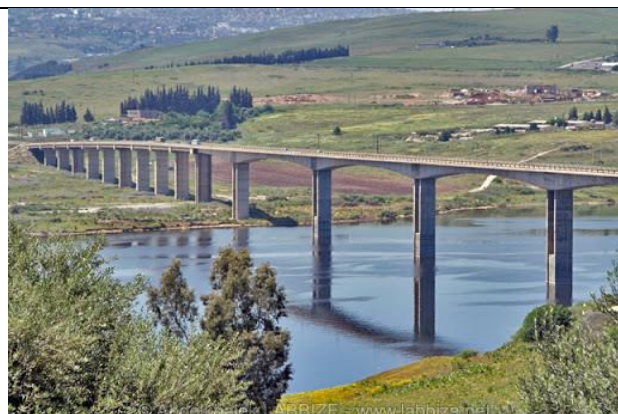
Viaduc ( en Beton precontraint)
