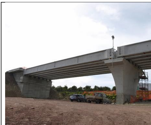
Pont en beton precontraint
