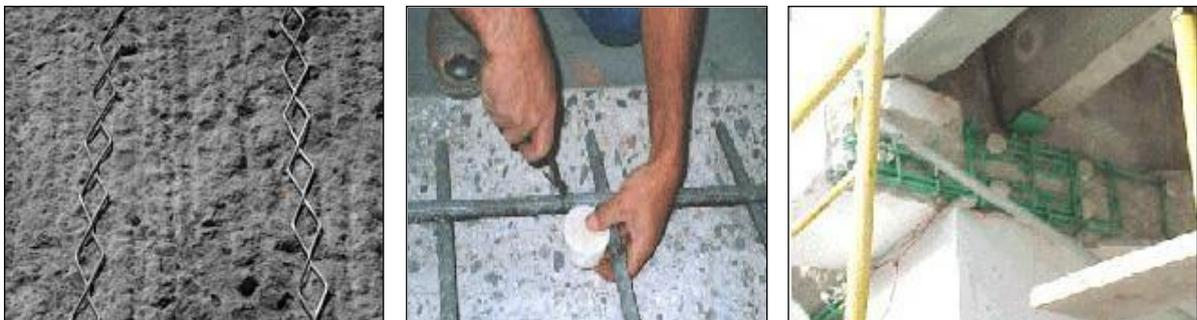
Anodes sacrificielles en zinc dans le béton
