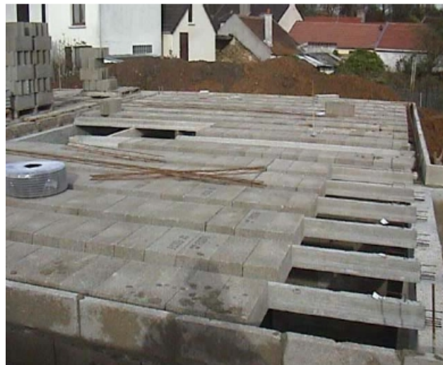
Figure 8 : Mise en œuvre des planchers avec poutrelles préfabriquées
