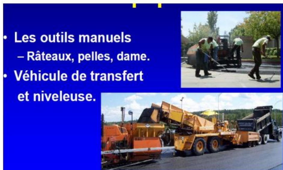
Fig. 6.10. Autres techniques de pose des enrobés
