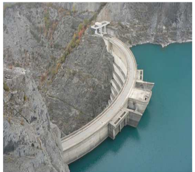
Figure II-12 : Le barrage de Monteynard (Isère, France)- voûte
