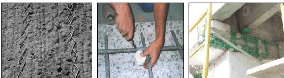
Figure IV-7 : Anodes sacrificielles en zinc dans le béton
