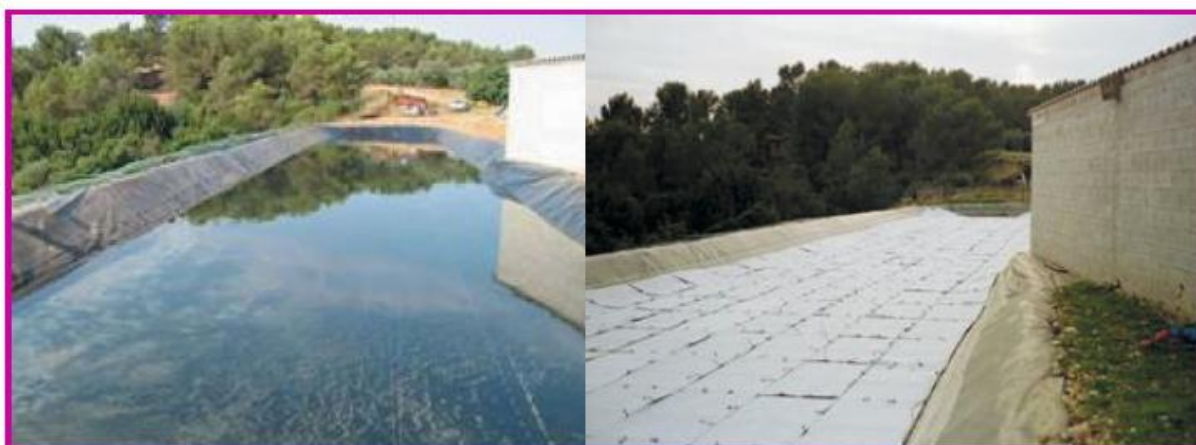
Figure IV.4: Bassin anaérobie d'une industrie agroalimentaire avec et sans couverture.
