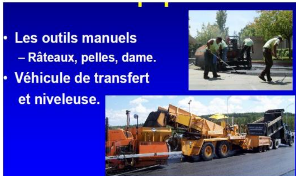
Fig. 6.10. Autres techniques de pose des enrobés
