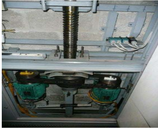
Figure III.7 : Mécanisme d'un ascenseur à vis
