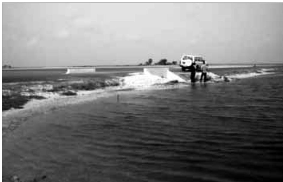
Pont de Palmarin. En 1979, la construction de la route avait bouché le bolon de Pandaka, entraînant un appauvrissement de la biodiversité et une érosion côtière. La construction du pont a permis de rétablir ces flux et d'atténuer les impacts de la route (Photo: Kane).
