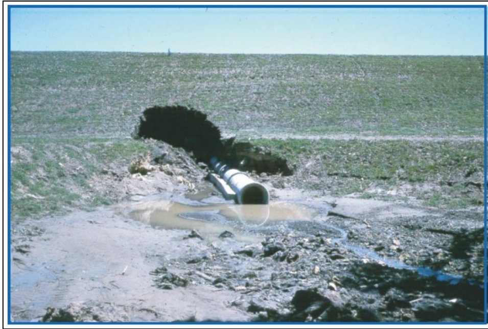
Figure 2.9 – Désordre causé dans un barrage en terre suite au développement d'un renard le long d'une conduite.
