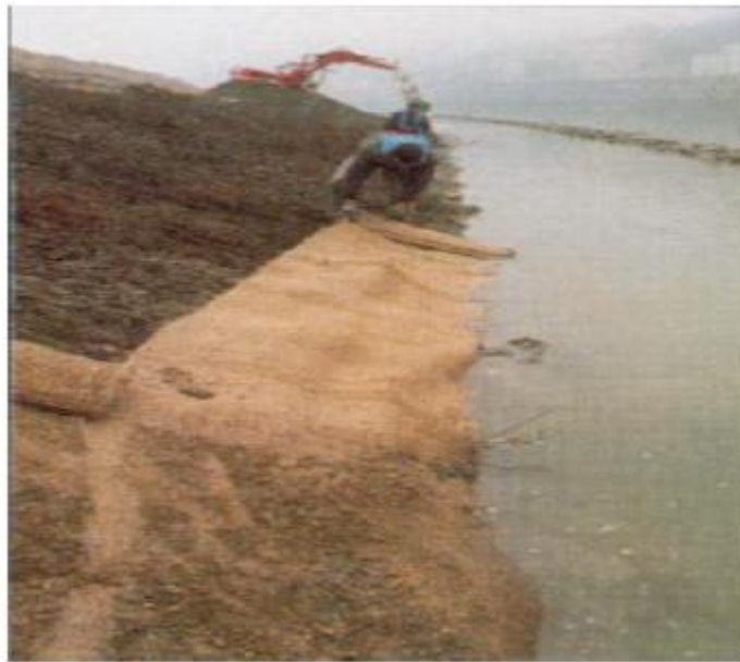
Figure 4.5. Mise en place de couches de branches et recouvrement avec un géotextile putrescible
