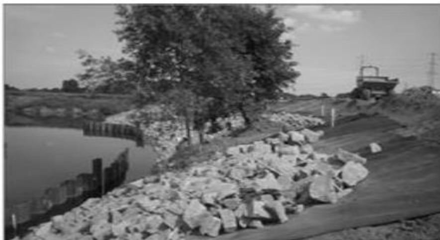
Figure 4.10. Revêtement en enrochement en construction sur un géotextile
