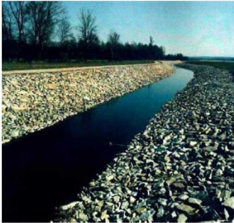
Figure.4.17. Enrochement pour les rivières en plaine
