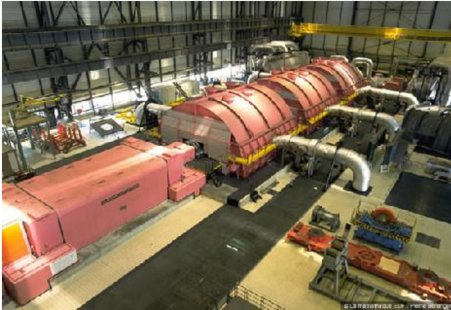
Fig. 9: Turbine et alternateur d'une centrale thermique
