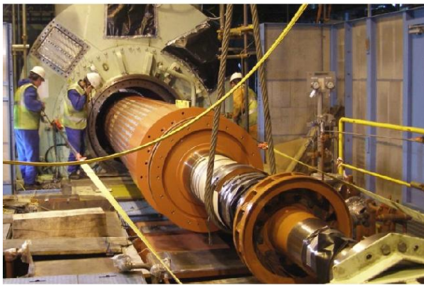
Fig. 10: Machine Synchrone à pôle lisses
