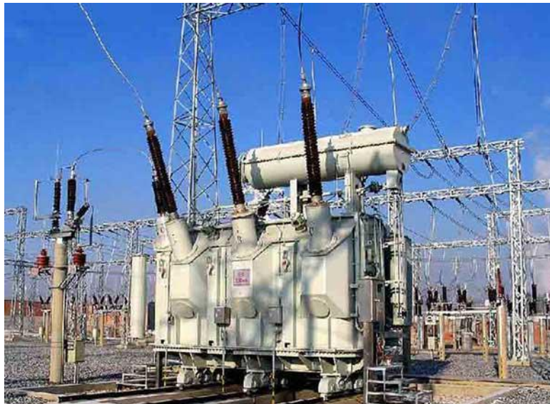
Fig 10 : Transformateur à la sortie d'une centrale
