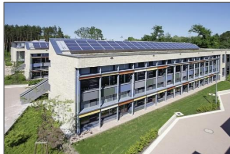
Fig.3 : bâtiment avec des panneaux photovoltaïques
