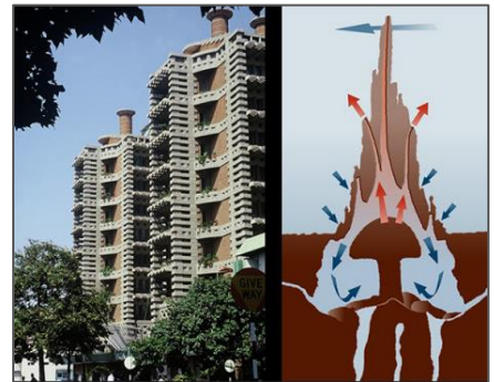
Fig.9 : l'Eastgate Building à Harare au Zimbabwe (le système de ventilation de la termitière)
