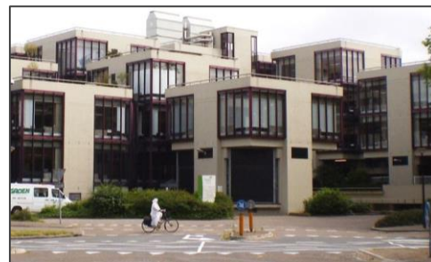
Fig.4 : Vue extérieure, les bureaux Centraal Beheer
