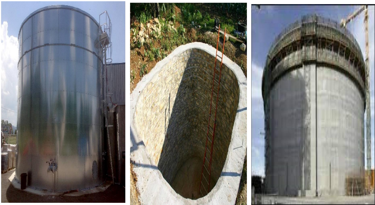
Figure 1 : Réservoirs métallique, maçonnerie, et béton armé
