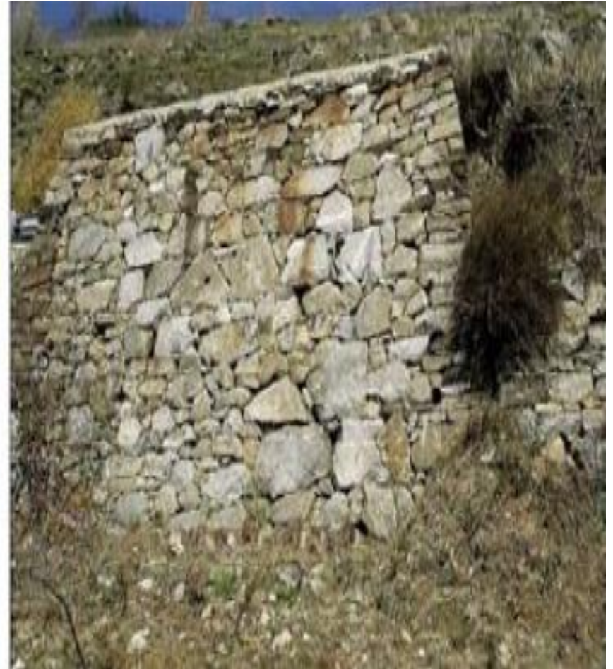
Mur en maçonnerie de pierres sèches avec absence de joint entre les pierres
