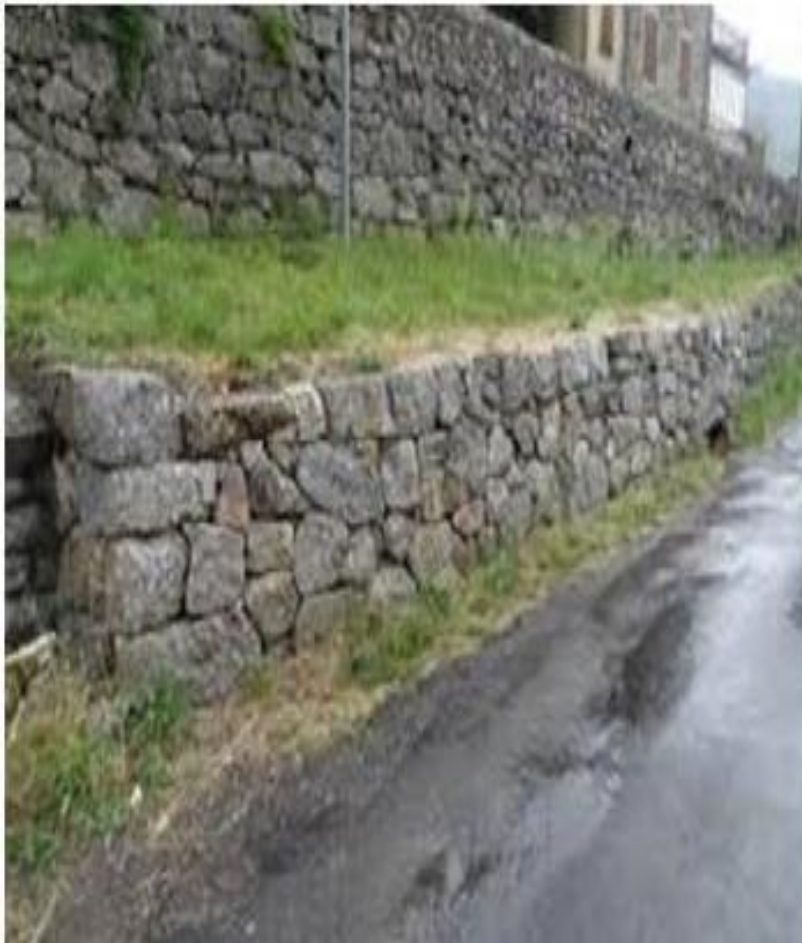
Mur en maçonnerie de pierres sèches avec absence de joint entre les pierres
