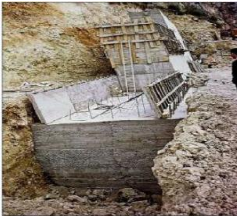
Murs poids en béton non armé: ouvrage en construction
