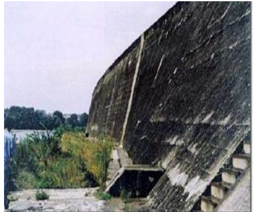
Murs poids en béton non armé: ouvrage en construction
