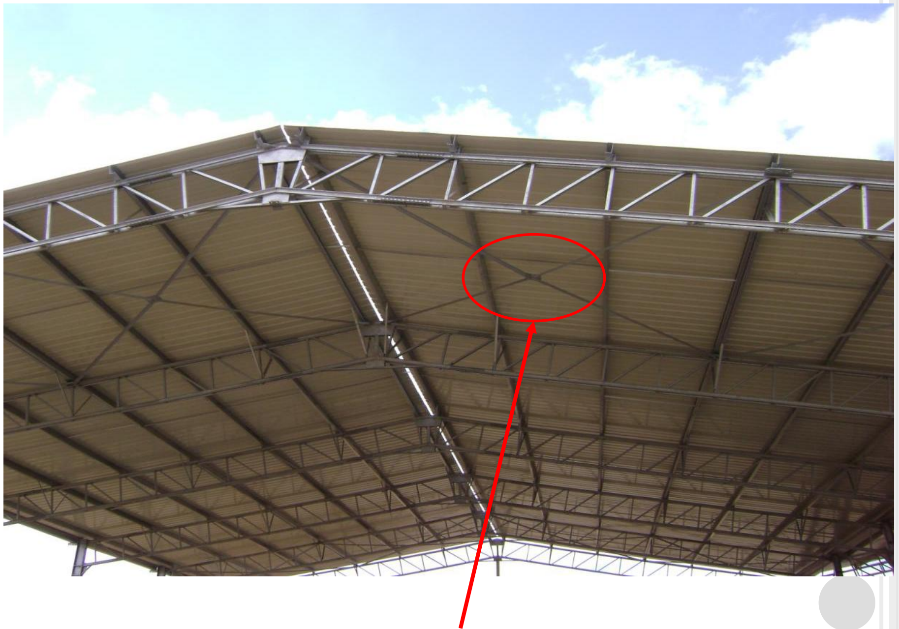
Contreventement horizontale en X d'une toiture d'un hangar en CM
