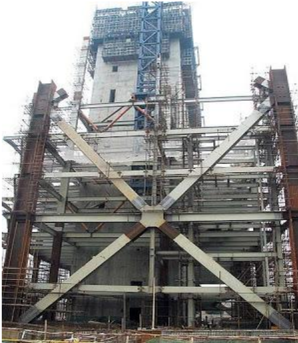
Construction de la Tour Pearl River. Les contreventements en X résistent aux efforts horizontaux causés par le vent ou les séismes Photo: Wikipedia Commons , 12 mars 2009.
