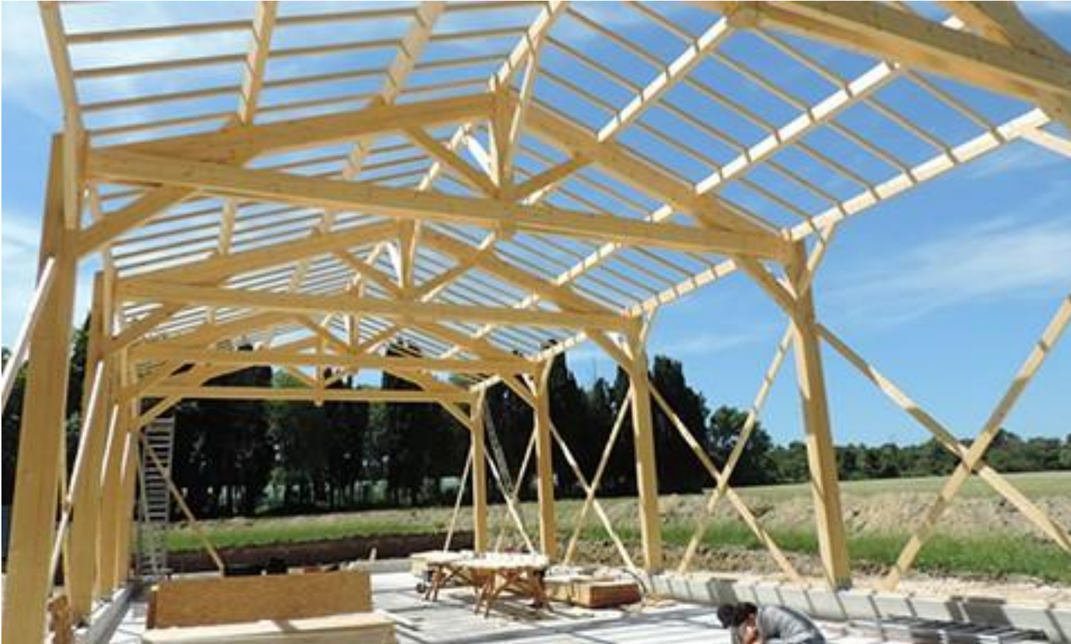
Contreventement en X d'une structure en bois
