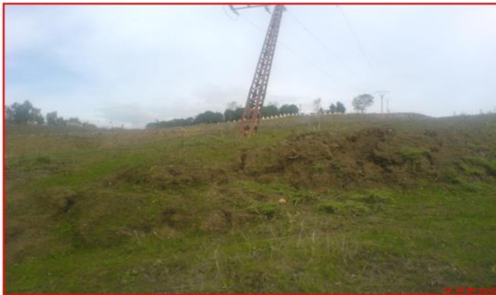
Photo. .2. Inclinaison de poteau électrique de haute tension suite à l'activation de glissement de terrain. (N.Hamadou, 2011))
