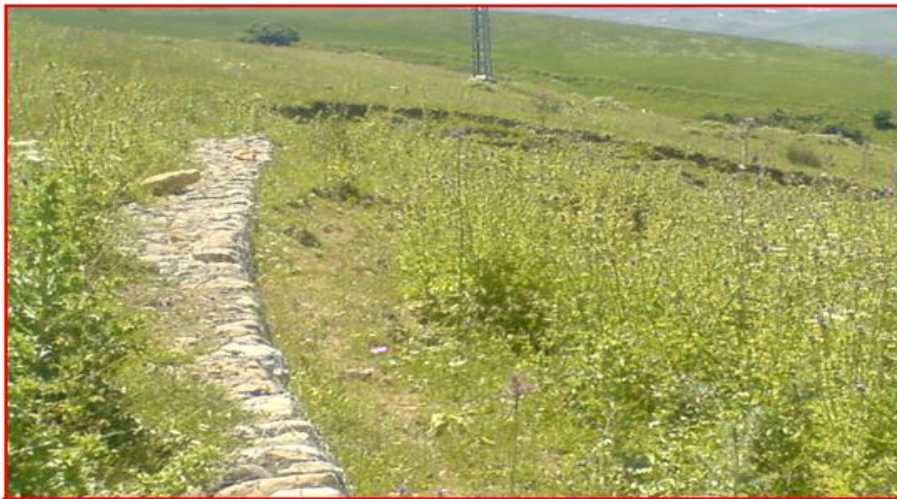
Photo..1. Gabionnage au sommet du glissement de terrain. (N. Hamadou, 2011).
