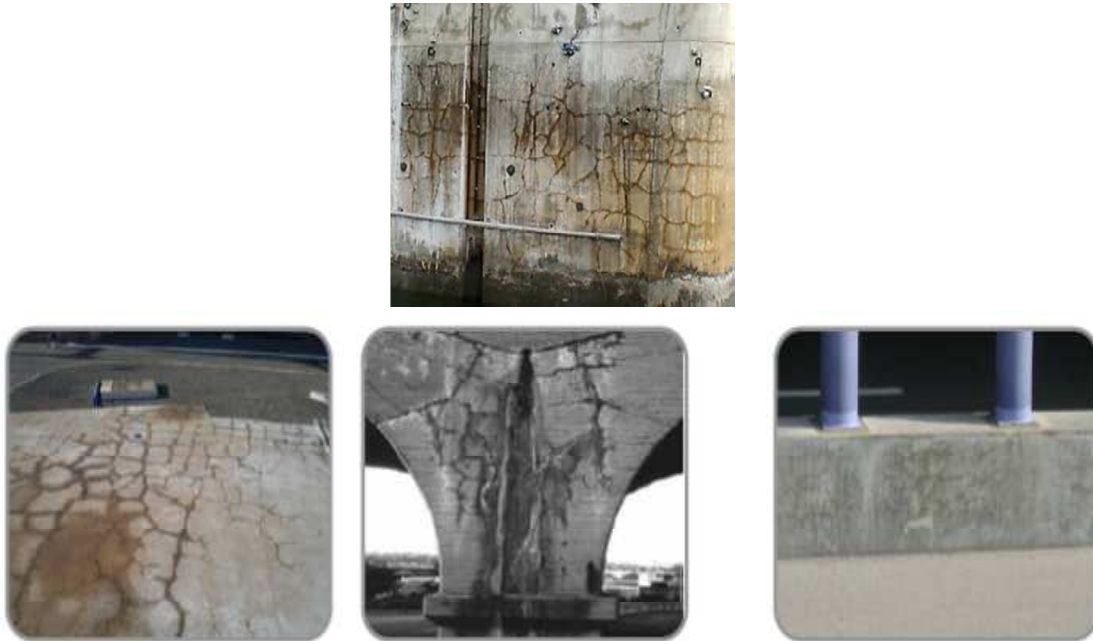
Figure 1.8 : Pathologie due à l'alcali réaction
