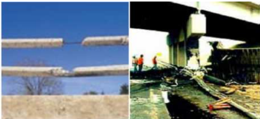
Figure I.4 : Choc sur une glissière de sécurité et une pile de pont
