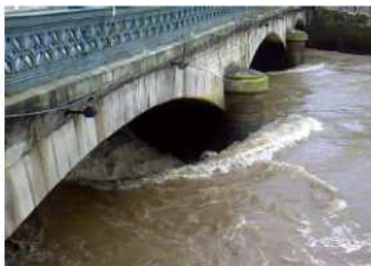
Figure II.11: désordres dus aux affouillements généralisés
