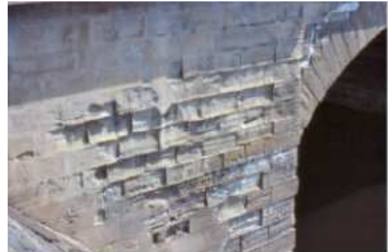
Figure II.13 : désordres dus à l'abrasion et l'érosion des matériaux
