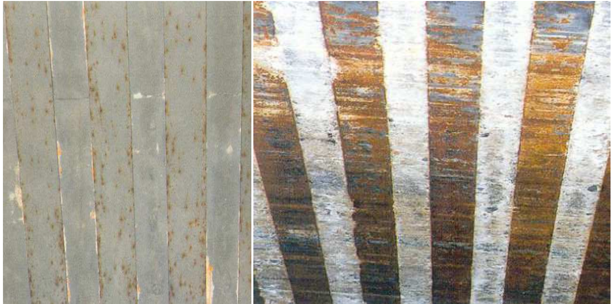
Figure II.3: piqûre de corrosion et corrosion généralisée des poutrelles métalliques enrobées
