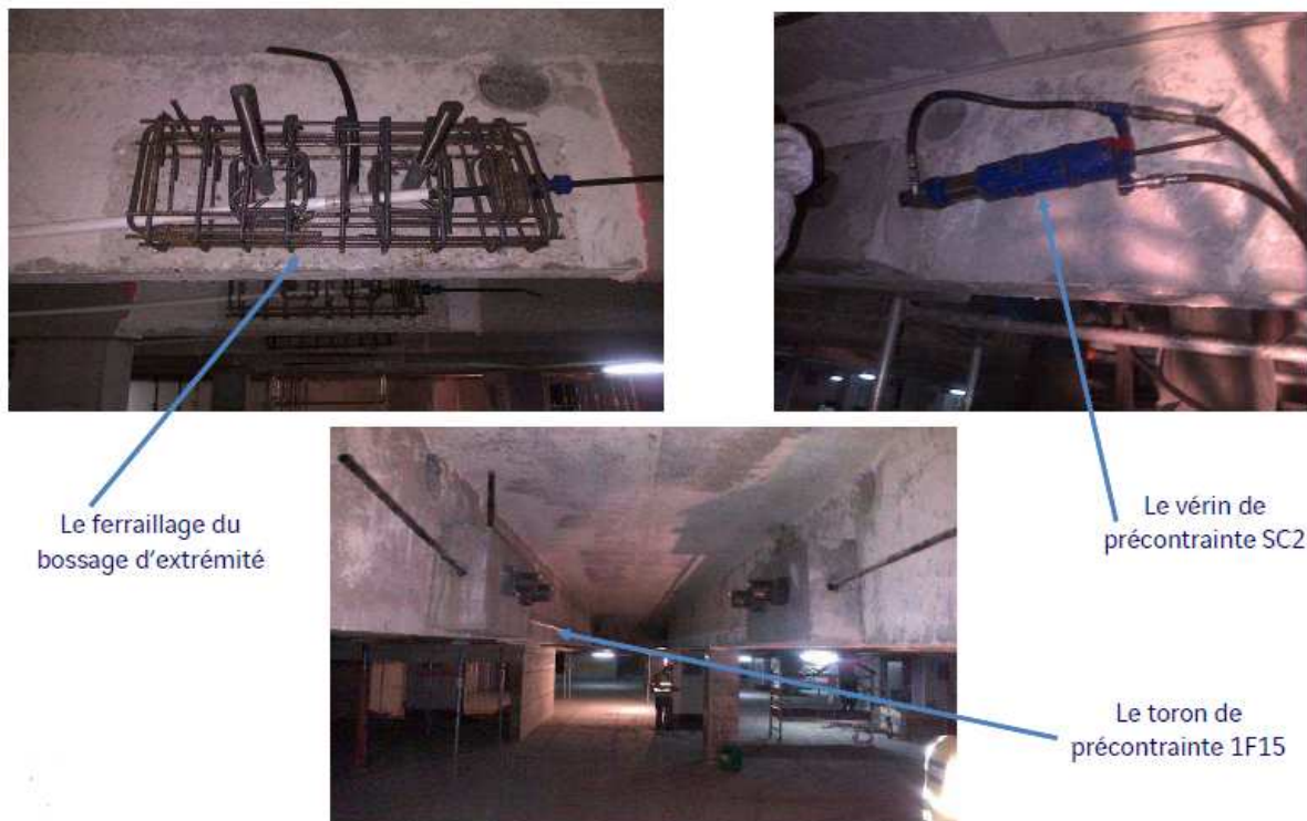
Figure IV.4 Une poutre renforcée par précontrainte additionnelle
