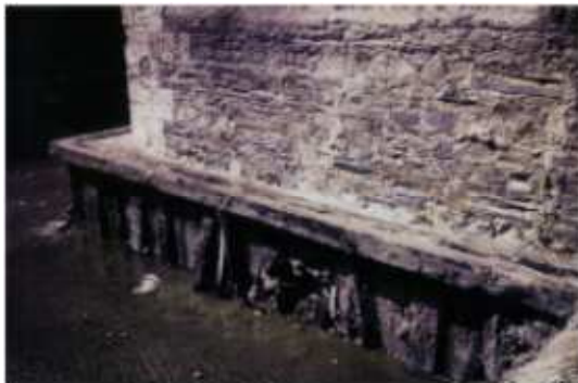
Figure II.13 : désordres dus à l'abrasion et l'érosion des matériaux
