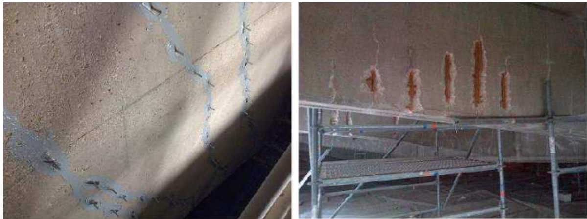
Figure IV.3 : Les injections de fissures et les réparations ponctuelles
