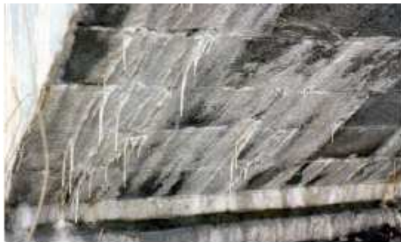
Figure II.14 : désordres dus à l'altération des mortiers et bétons
