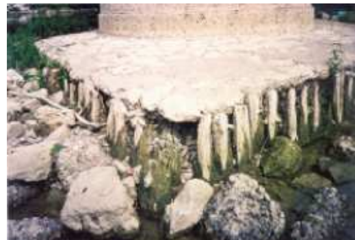
Figure II.14 : désordres dus à l'altération des mortiers et bétons
