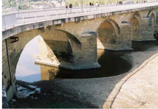
Figure II.12 : désordres dus aux affouillements locaux
