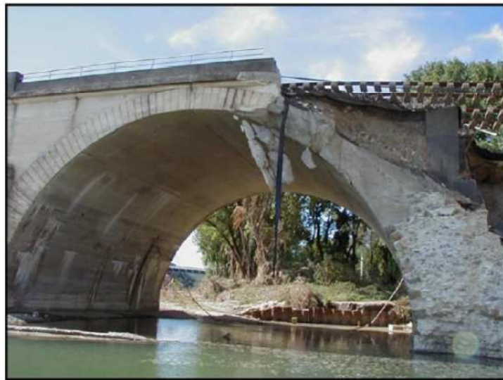
Figure II.10 : Affouillement d'une fondation d'ouvrage en rivière
