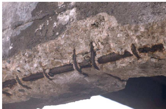
Figure II.5: dégradation d'un pont à poutre en béton
