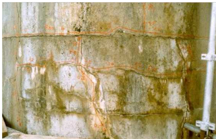
Figure 1.6 : Pathologie due à l'attaque des sulfates
