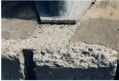
Figure I.9. : dégradation due au gel-dégel
