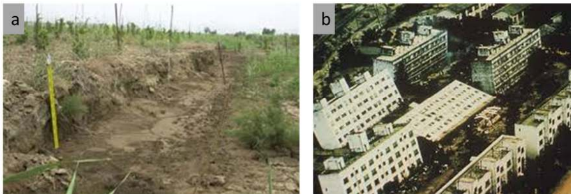
Figure II. 8. a) Sites affectés par la liquéfaction [14], b) Immeubles partiellement enfouis et ayant basculé à la faveur d'une liquéfaction du sol lors du séisme de 1964 à Niigata, au Japon [15].
