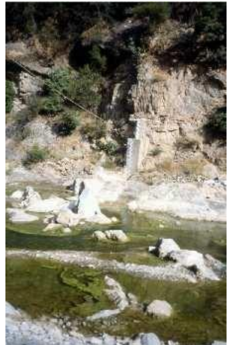
Exemples de seuil artificiel et d'un contrôle naturel par affleurement d'une couche résistante
