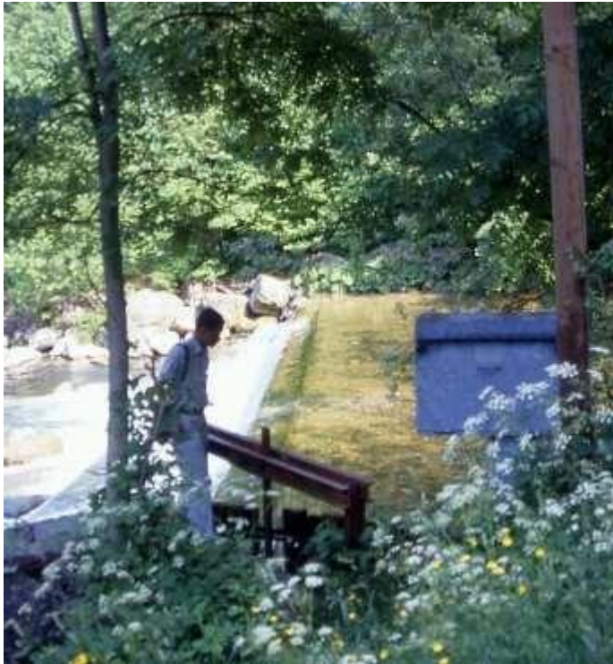
Exemples de seuil artificiel et d'un contrôle naturel par affleurement d'une couche résistante
