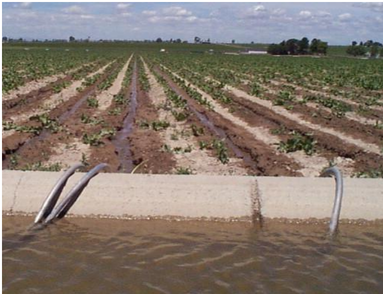
Figure 16 : Alimentation des sillons par siphons (Bjorneberg, 2005)
