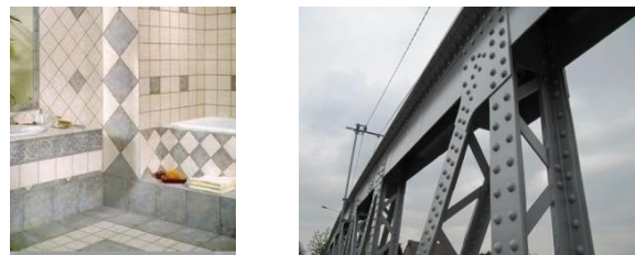
Fig. 1.15 Liaison indémontable
