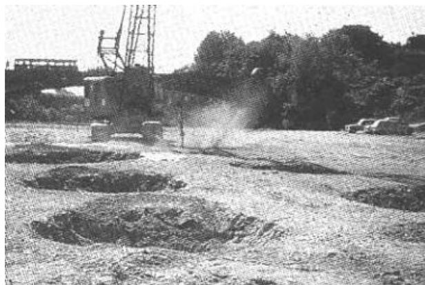
Figure 21 – Chantier de pilonnage
