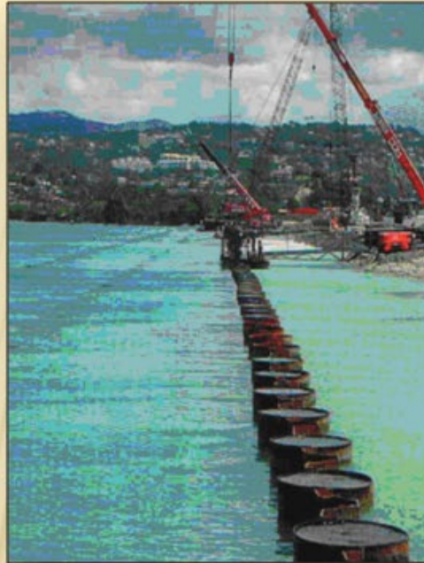
Réalisation d'un mur de quai composé de rideaux de palplanches et de pieux tubulaires en béton armé (Guadeloupe).
