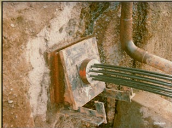
Tête d'un tirant d'ancrage précontraint en post-tension
