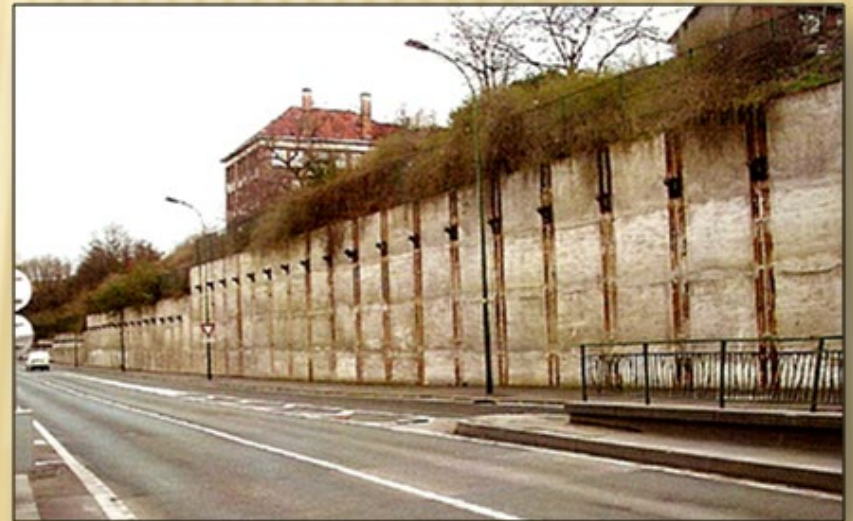
Vue générale des parois Berlinoises à Saint-Ouen (France)
