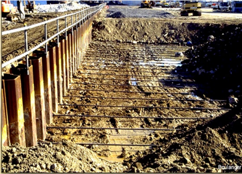
Rideaux de Palplanche ancré par des tirants d'ancrages
