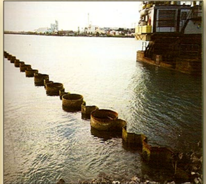
Réalisation d'un mur de quai composé de rideaux de palplanches et de pieux tubulaires en béton armé (Guadeloupe).
