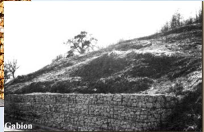
Mur poids en gabions
