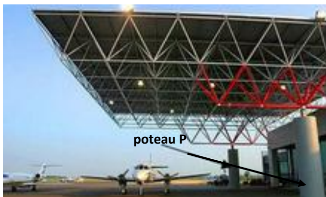
Figure '3' poteau en béton Armé de 4m de longueur
