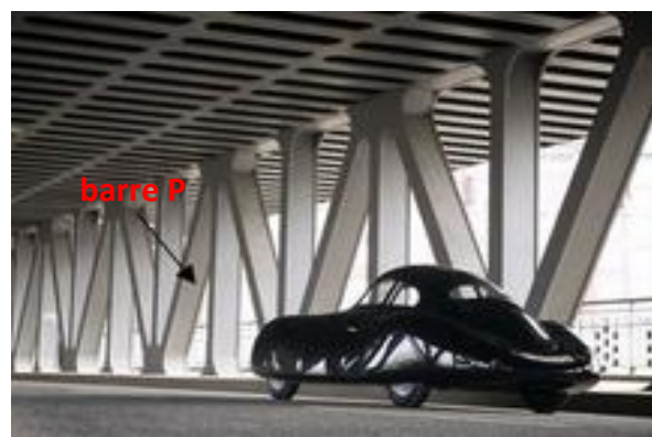
Figure '4' barre du treillis d'un pont soumise au flambement de 8m de longueur
