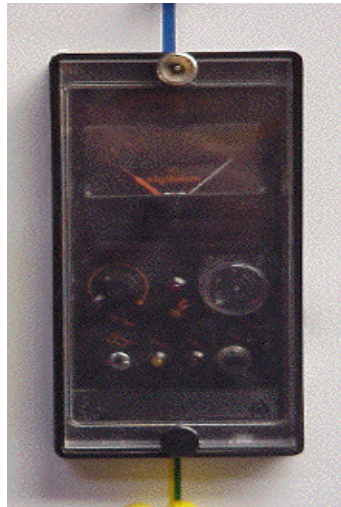
Fig.III.16 signalisation de premier défaut (CPI)
