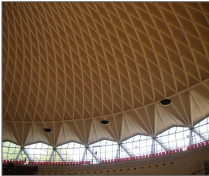
Fig.6 : Béton à nervures-à gauche : le palais des sports de Rome-à droite : hangar pour avions
