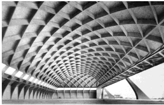
Fig.6 : Béton à nervures-à gauche : le palais des sports de Rome-à droite : hangar pour avions
