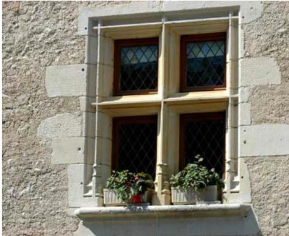
Exemple d'un meneau croisé sur bâtiment historique
