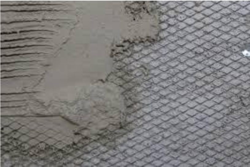
pose d'un grillage galvanisé
