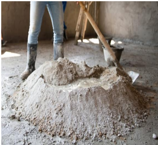
mortier de chantier
