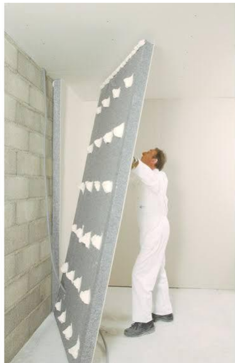
Panneau composé d'un isolant en polystyrène et d'un parement en plaque de plâtre collé sur un mur en maçonnerie
