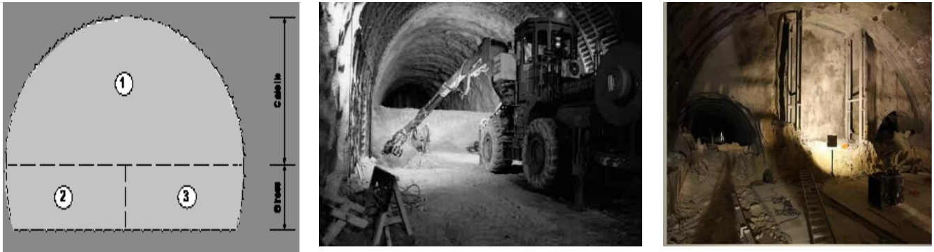
Figure (3.7) : Creusement en demi-section supérieure
