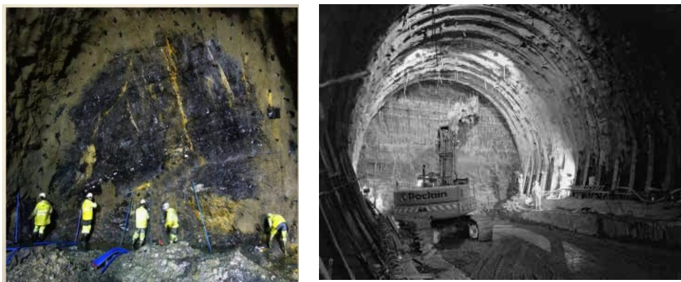
Figure (3.6) : Creusement en pleine section
