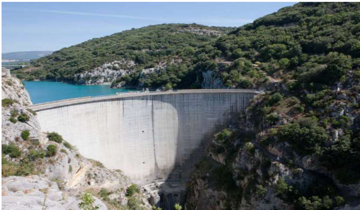
Vue aérienne du barrage de Ste Croix du Verdon en France
