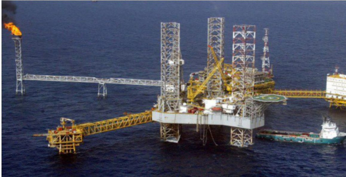
Plateforme pétrolière en mer
