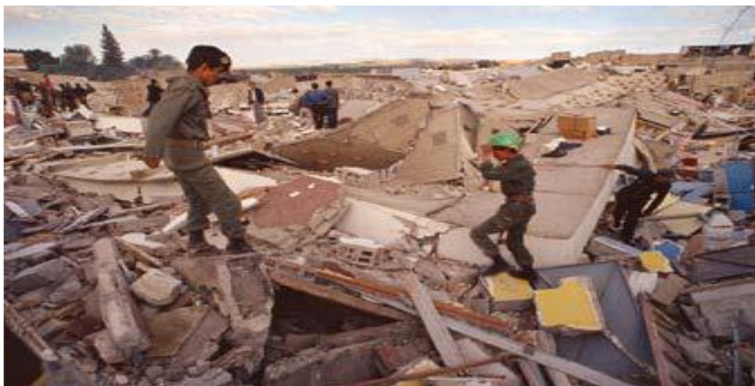
Figure 9 : Vulnérabilité du bâti de la ville de Chlef (Algérie) : Leçons tirés du séisme de 1980
