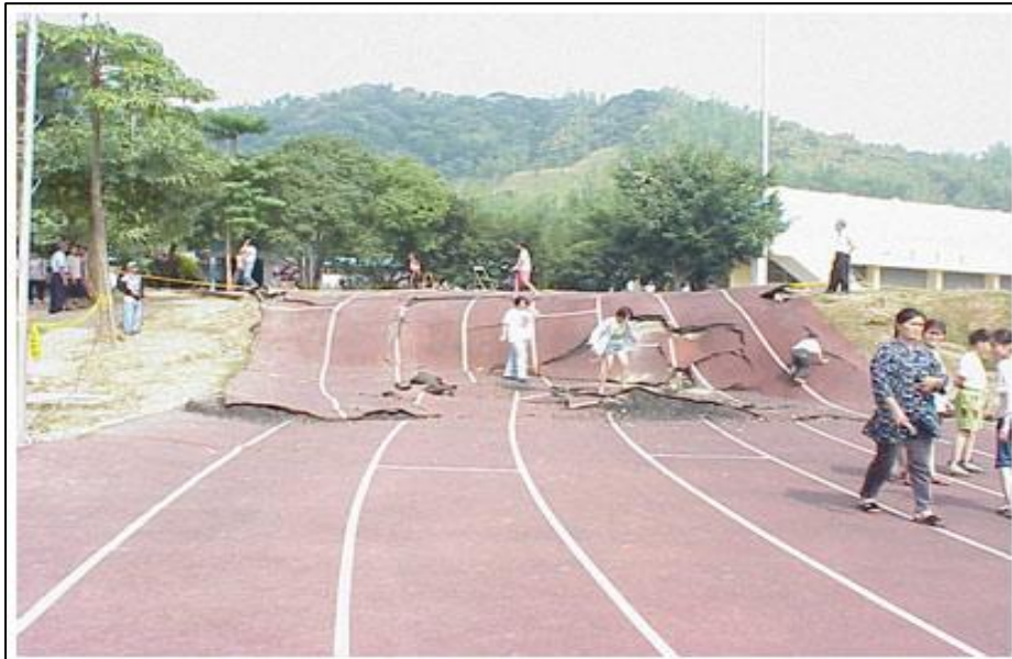
Déplacement vertical associé à l'émergence de la faille, lors du séisme de Chichi à Taiwan (magnitude 7,6), en 1999 (photo IRSN/AFPS)
