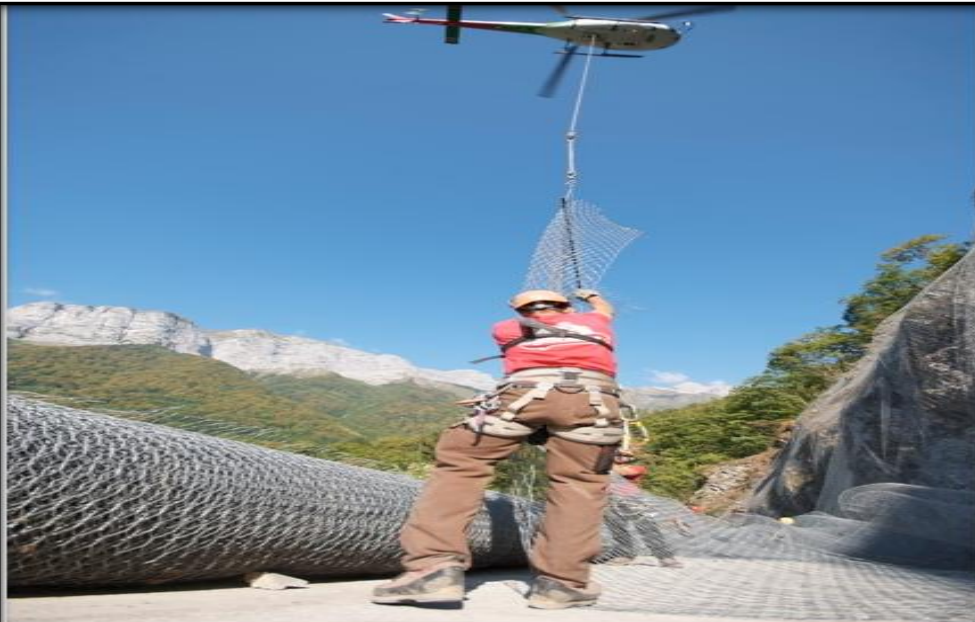
DÉROULAGE DE GRILLAGE À L'HELICOPTÈRE-RD12
