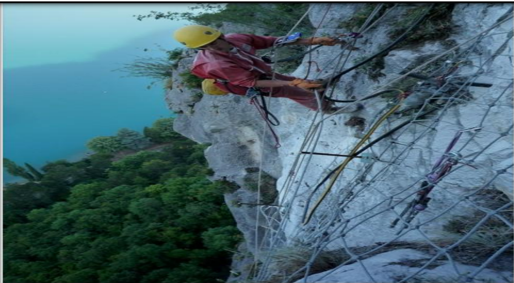
POSE DE FILETS DE CÂBLES-RD 909
