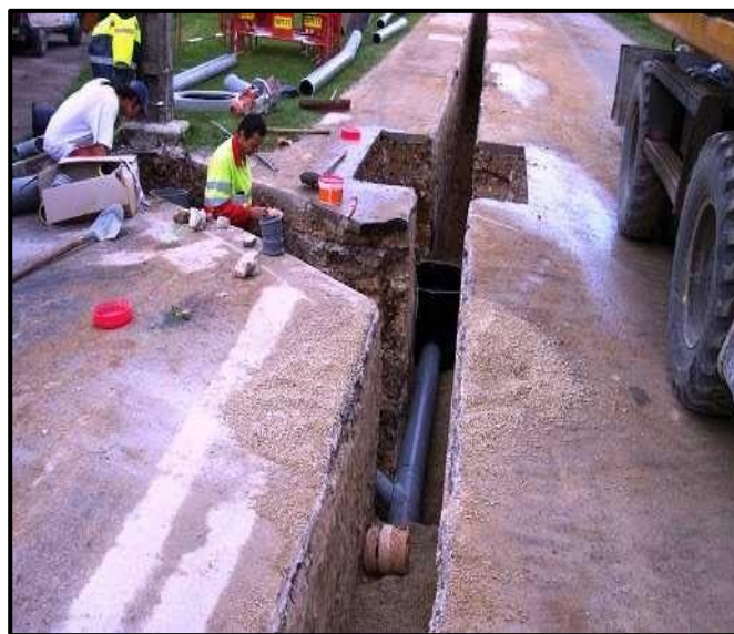
Photographie. 16: Pose de canalisation D'assainissement.
