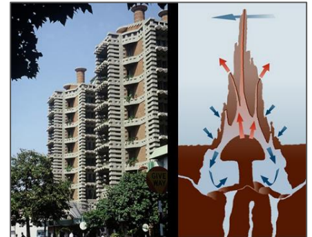
Fig.9 : L'Eastgate Building à Harare au Zimbabwe (le système de ventilation de la termitière)
