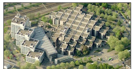
Fig.3 : Vue générale, les bureaux Centraal Beheer
