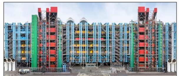
Fig.1 : Façade Est (rue Beaubourg)
