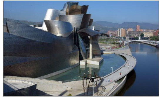
Fig.2 : Vue extérieure_ Musée Guggenheim de Bilbao
