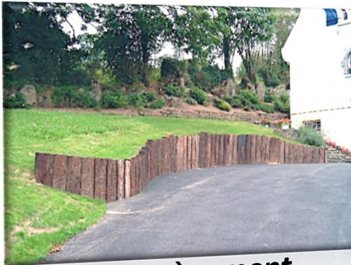
Mur de soutènement en palplanche en bois
