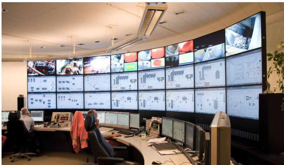
Figure 1.2 : Supervision d'un processus industriel complexe depuis une salle de contrôle (les écrans affichent d'une manière graphique le flux des informations provenant des équipements de terrain).
