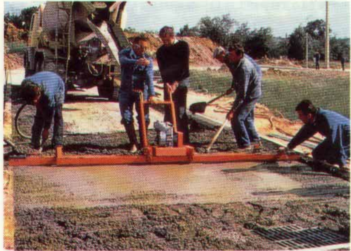
La règle déplacée sur deux rails de niveau assure la planéité de la dalle.
