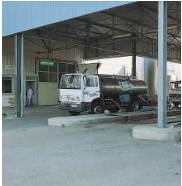
Dans une laiterie : aire de dépotage et de nettoyage des citernes, réalisée en béton de ciment alumineux fondu.
