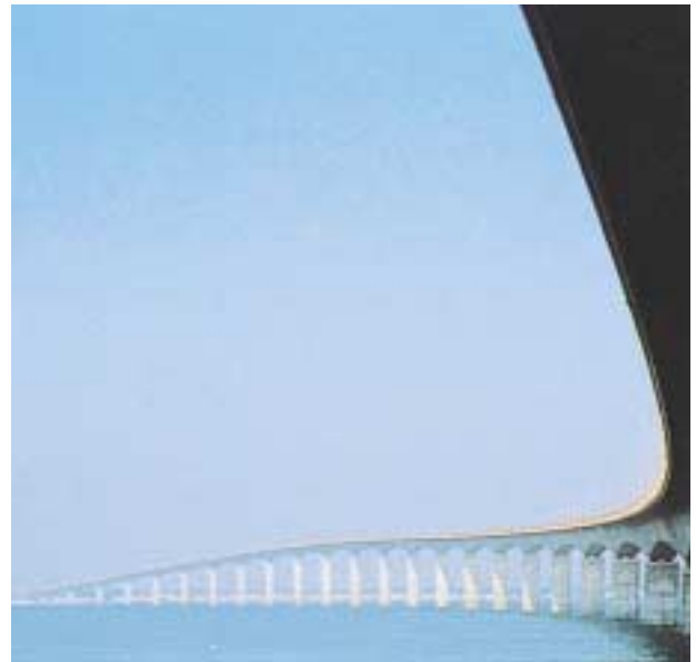
Béton HP (60 MPa) choisi aussi pour sa rapidité de prise : le pont de l'Île-de-Ré.
