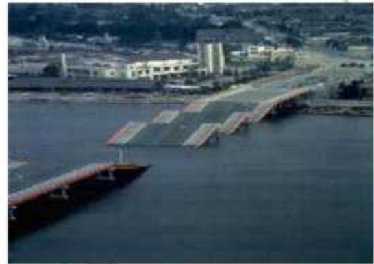
b: Rupture du pont de Showa, à Niigata au Japon,
