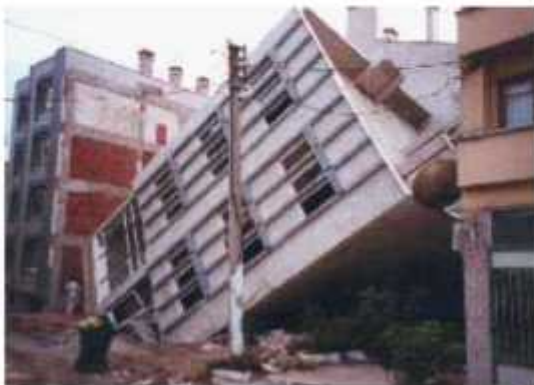
c: renversement d'une structure sisme Adapazari, Turquie 1999 .
