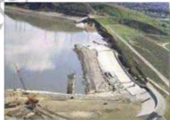
d: effondrement du parement amont du barrage de San Fernando 1971
