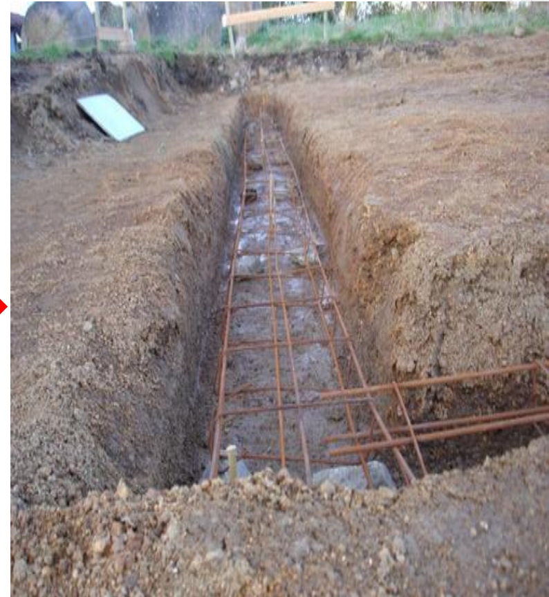
Fouille en rigole ou en tranchée
